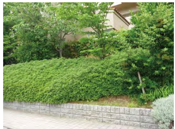
コンクリート擁壁とせず、法面処理と植栽により通りからの眺めに配慮している例
