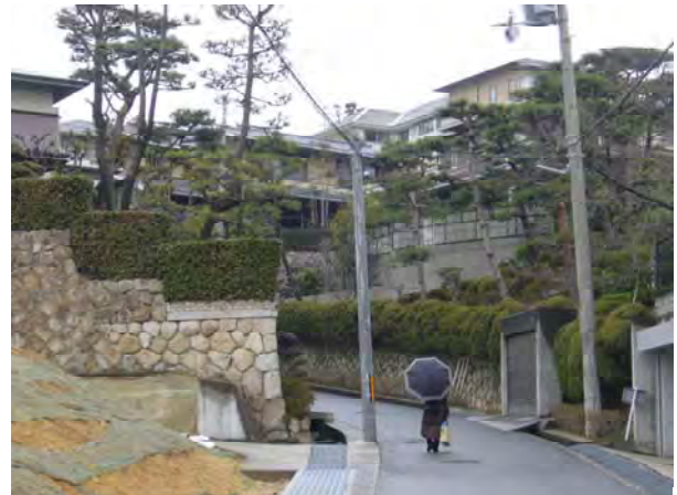
擁壁を徐々に立ち上げ、緑化した法面と効果的に組み合わせている例
