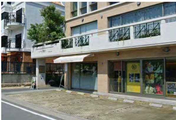
駐車場の車路の舗装を工夫し、路面を緑の空間としてしつらえている例
