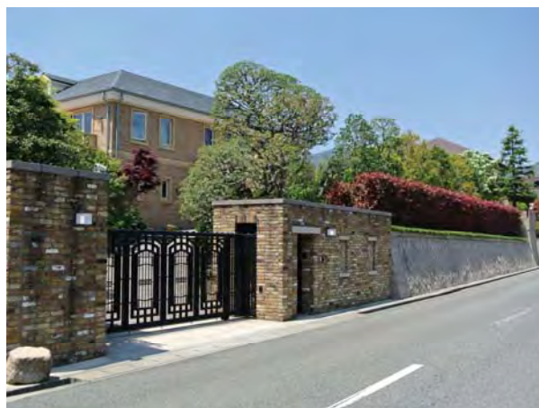
レンガの門柱を配置し、質の高い空間を演出している例
