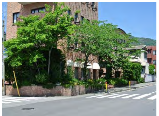
派手さではなく、建築デザインの質によって街角を特徴づけている商業施設の例
