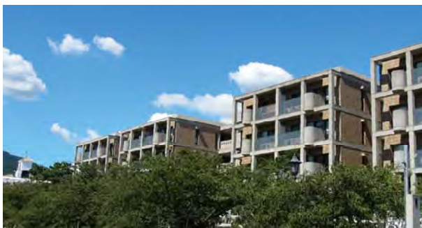
周辺の建築ボリュームに合わせ壁面を分節している大規模な中層集合住宅の例
