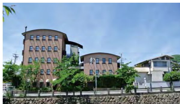
塔屋や屋根のデザインを工夫してリズムカルなスカイラインを形成している例
