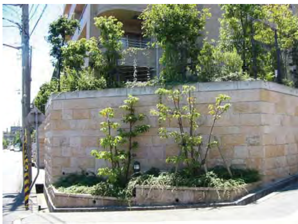
石積み擁壁と前面と上部に修景植栽を施し、圧迫感を軽減した例
