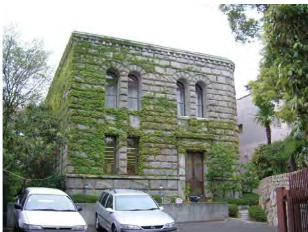
経年に耐えて風合いを増す自然石のこぶ出し等による味わい深い仕上げの例
