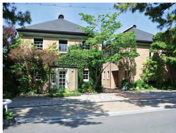
外構素材や建築物の明度を隣地の施設と近いものになっている例
