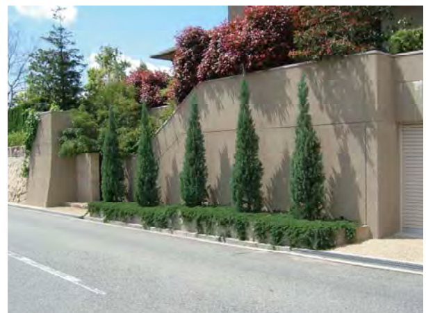
擁壁の全面の上部に修景植栽を施し圧迫感を軽減した例
