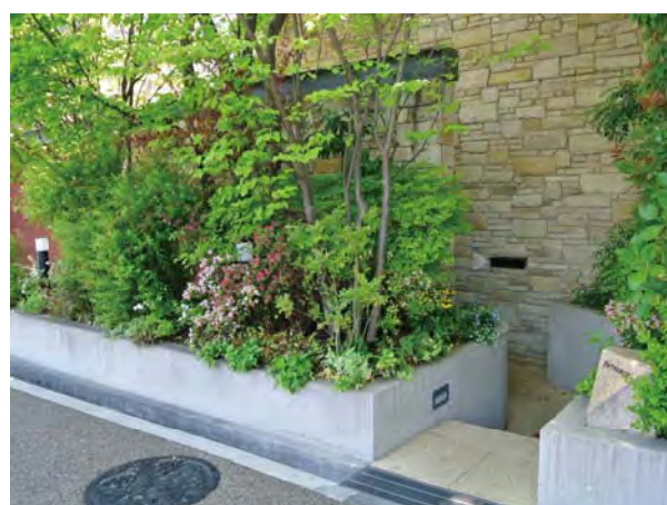
石貼りの外壁と前面の多様な植栽による味わい深い低層部としている例
