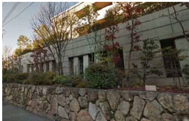
建築物壁面を背景とし、低い石積み擁壁の上部に植栽を効果的に配置して開放感を生み出す
