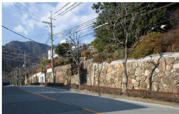
既存の石積みを残し、石積み上部の植栽とあわせて街路樹と一体となった、うるおいある通り外観を形成する
