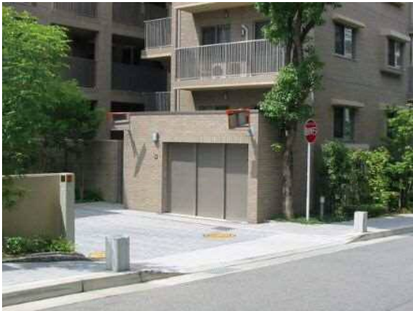
ゴミ置場を道路から見えにくい位置に配置するとともに、建築物の意匠及び素材と一体的にデザインする
