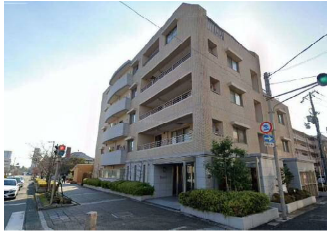
通り面のデザインを分節し、正面の素材を側面に回り込ませ、景観に配慮する
