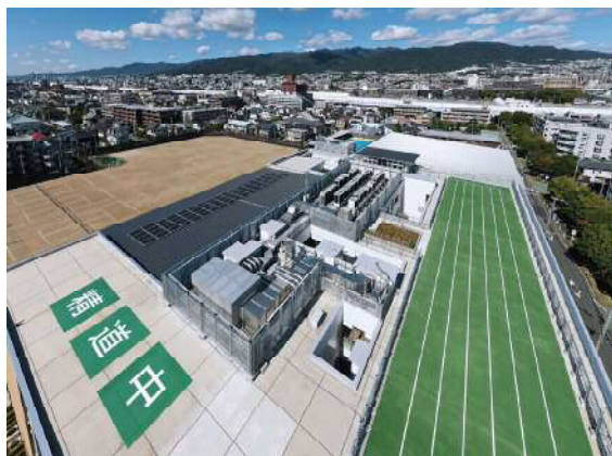
付属設備は屋上の中央に配置することにより、周辺から見えないよう工夫する
