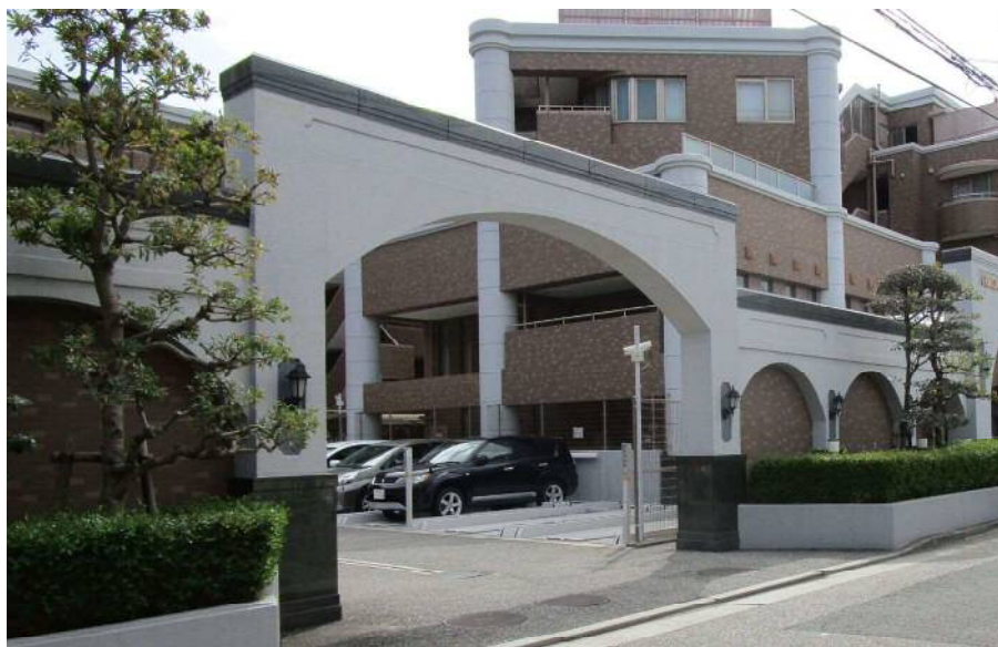
建築物と塀の意匠を調和させ、地上一段の機械式駐車場と植栽等の組み合わせにより、景観に配慮する
