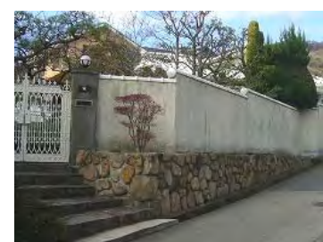
玉石積みによる擁壁の例
