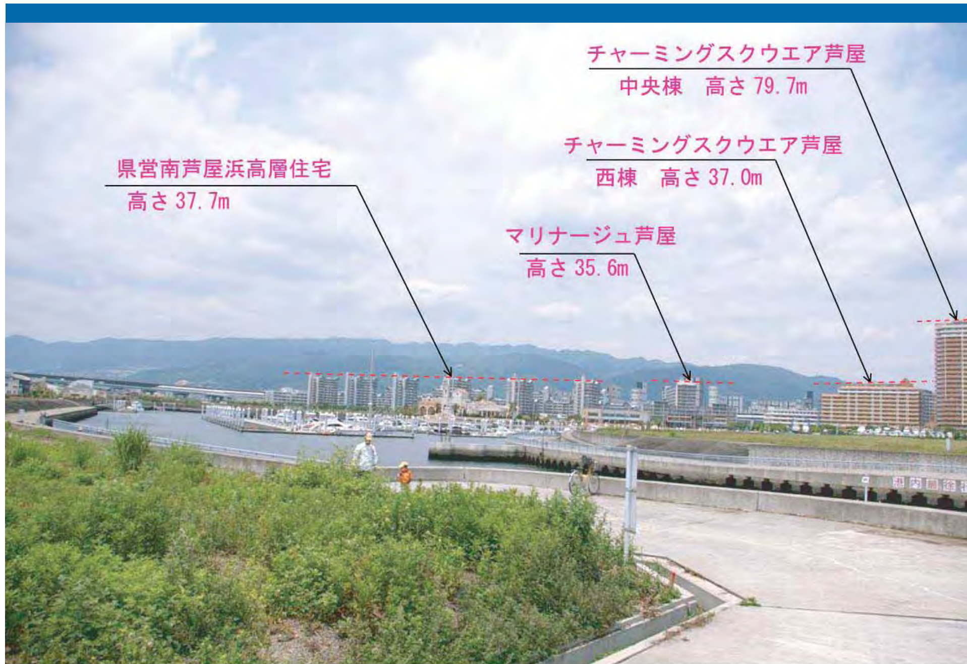
③ フリーゾーン対岸より（六甲最高峰方向）
