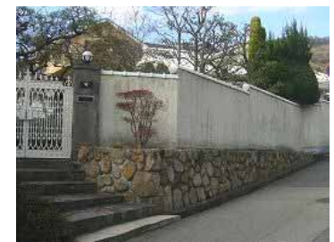
玉石積みによる擁壁の例
