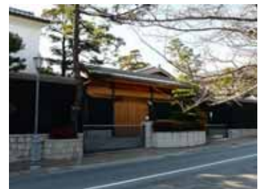
屋敷の門と木塀の例
