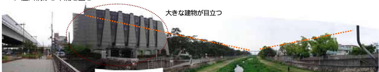
芦屋川橋から下流を望む
