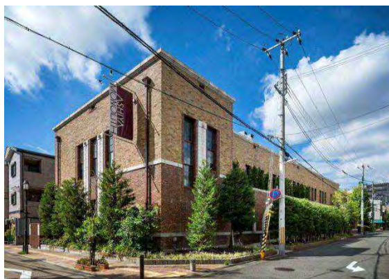
旧芦屋郵便局電話事務室（外観）
