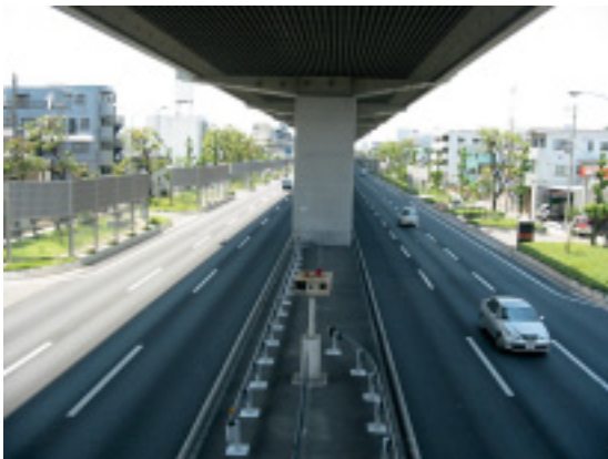
広域防災帯 国道43号（竹園町・精道町）
