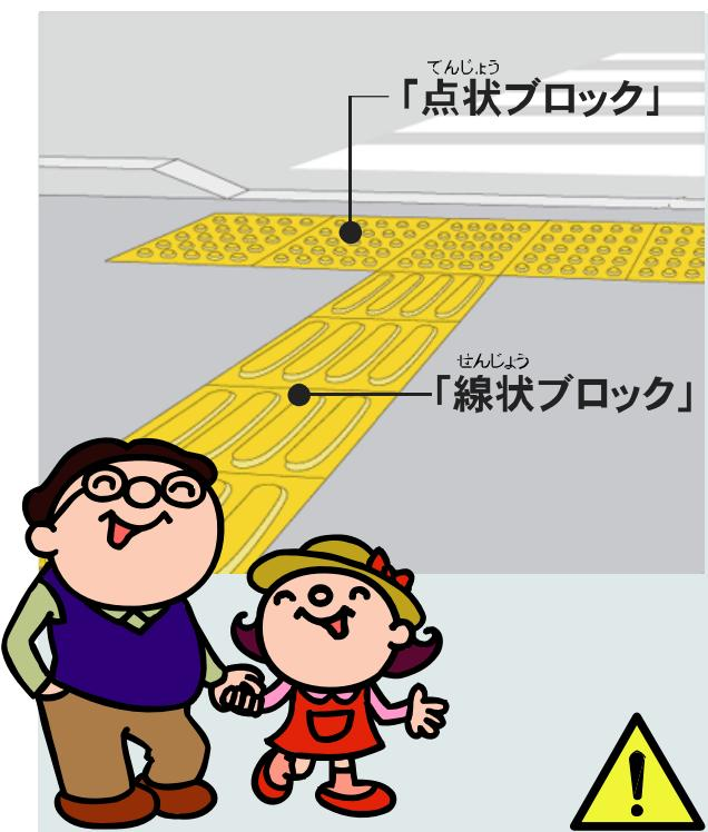
「点状ブロック」は、注意を示します。通常、「線状ブロック」の両端(横断歩道の手前・階段の手前・案内板の手前)や、交差する部分に設置されています。交差する場所、いったん停止して段差や扉を知るために設置します。
