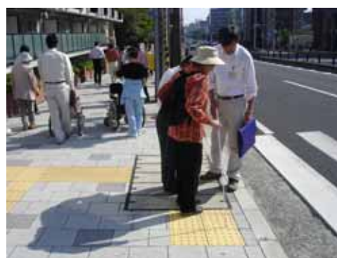
【現地点検調査】
