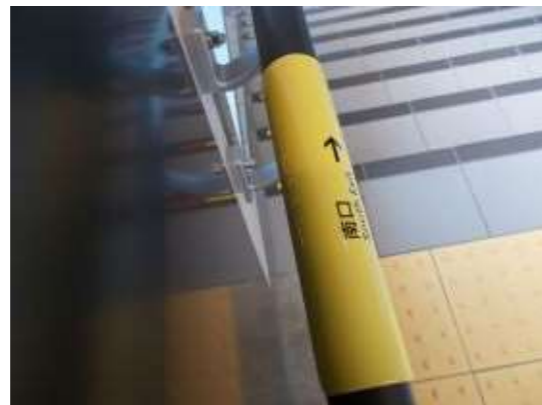
手すりの写真（点字あり）（新）
