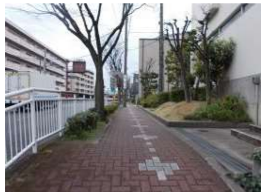
歩道部の写真(現況)
