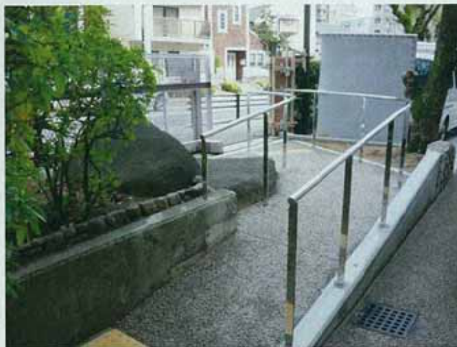
別館駐車場横のスロープ
