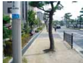
◀ 歩道の有効幅員が狭く路面が凸凹
