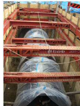
【耐震性貯水槽の設置工事の様子】
