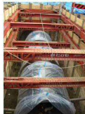
【耐震性貯水槽の設置工事の様子】
