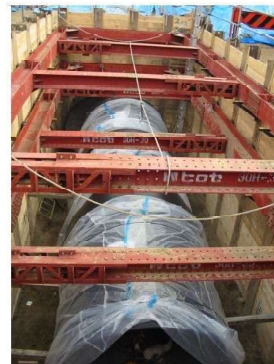
【耐震性貯水槽の設置工事の様子】
