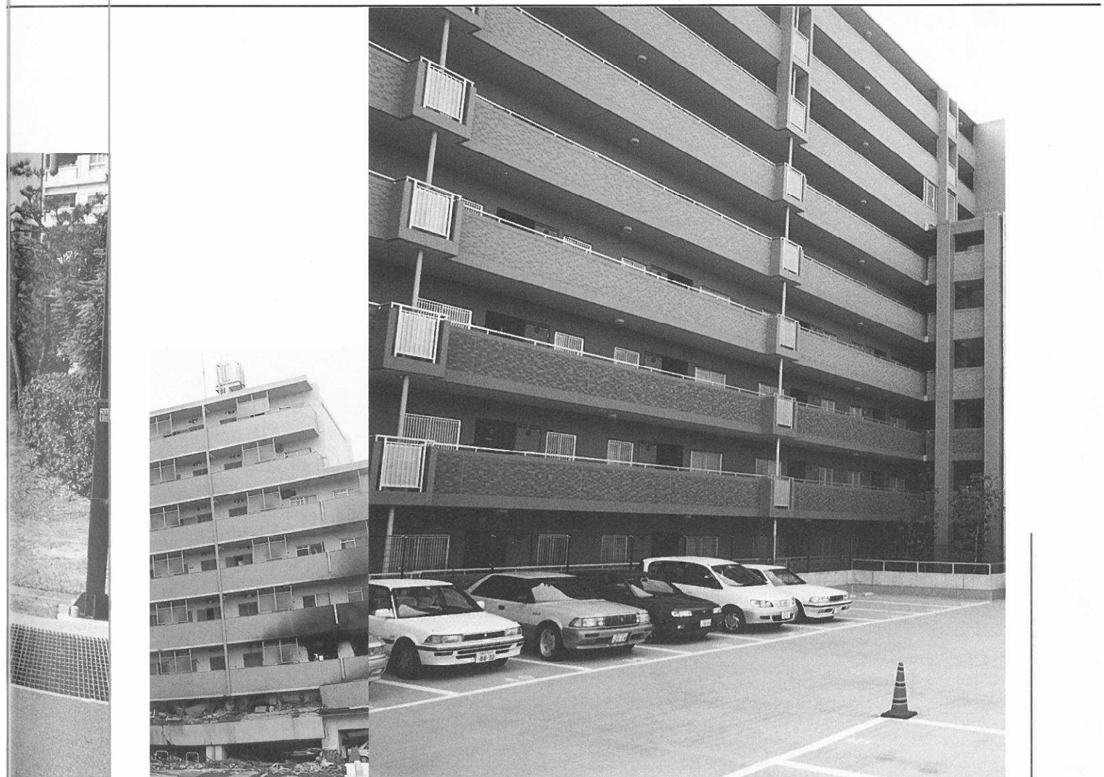
▲復旧前 ▲復旧後
