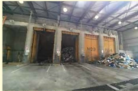
ごみピット(上記の写真)に投入されたごみの中から法に定める基準値を超える水銀濃度が検出されたため焼却炉を停止(8月27日)。現在は運転を再開
