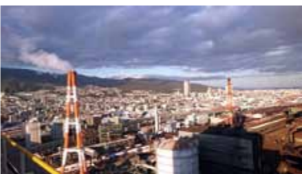
増設が予定されている神鋼の石炭火力発電所
