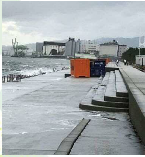
2018年台風第21号 芦屋市南芦屋浜浸水被害
