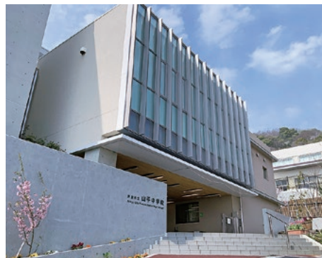
建て替え工事が完了した山手中学校
