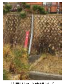
芦屋川の水位観測所(阪急芦屋川駅南)
