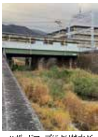
ハザードマップにより越水が想定される阪急芦屋川駅付近
