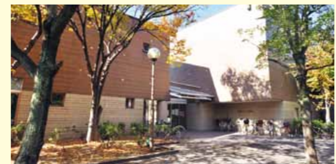
大規模改修工事中の図書館本館(平成31年4月2日まで休館しています)
