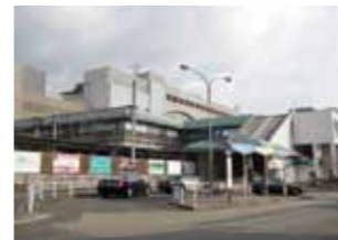
JR芦屋駅北地区と一体的な整備が求められるJR芦屋駅南地区
