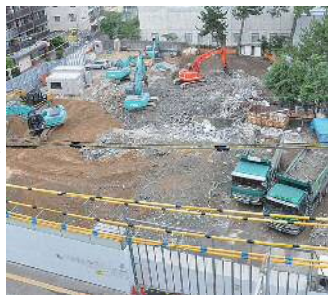
新庁舎建設に伴い解体が行われた旧消防庁舎
