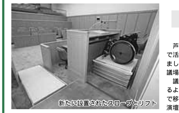
新たに設置されたスロープとリフト
