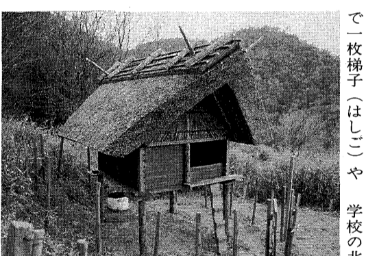
新しく復原が完了した弥生文化期の高床倉庫
