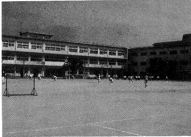
年次計画を練り上げ、校舎の内部改修が行われる 精道中学校の校舎
