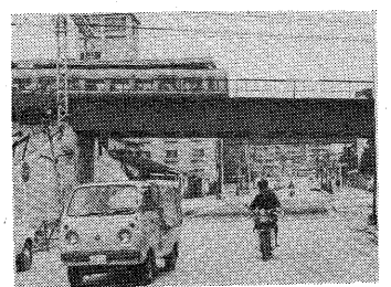
市道川西線の西側を南北に走る市道川西線と阪神電鉄が立体交差している部分の拡幅工事が、先月二十日に完成しました。この工事で、これまで六車線だった道幅は、十車線となり、九車線の車道と五車線の歩道が両側にできまし。また、ガードの高さも四・五メートルと高くなっています。
