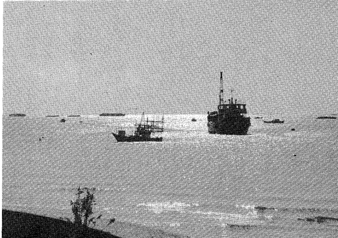
埋立工事は順調に進み、来春には海面に土砂が見えはじめます。
