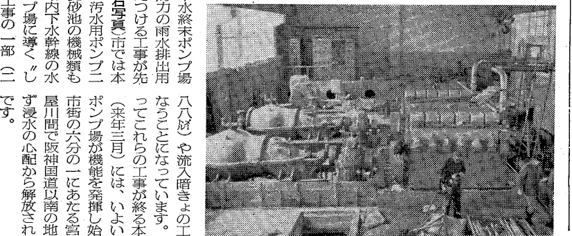
すえ付け終った雨水用ポンプ
