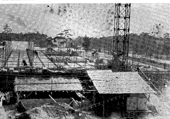
二階のコンクリート打ち
