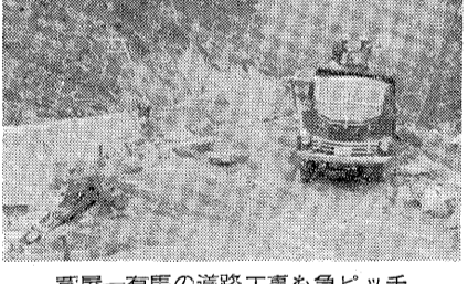
芦屋一有馬の道路工事も急ピッチ
