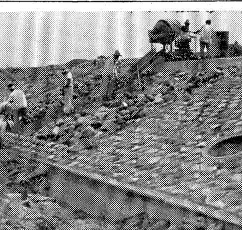
工事の大半を完了し、余すところわずかとなった防潮堤補強工事 (2面記事参照)
