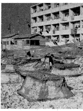
大東町の新市住も着工 ..... 32年度市営住宅建設は南宮町の18戸に引き続き、大東町70番地でも4階建24戸の鉄筋住宅が着工され、いま基礎工事中です。
