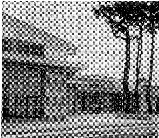
精道幼稚園新園舎
