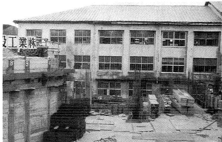
学校園施設整備10億4,863万円(工事が進む岩園小学校体育館新築工事)
