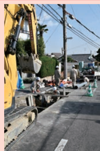
▲さくら参道(朝日ヶ丘町) (現在工事中 ～2019年度完了予定) あしや霊園につづく通称「さくら参道」で無電柱化工事を行っています。平成31年度に工事完了予定であり、その後、電気通信事業者が電柱と電線を撤去する予定です。
