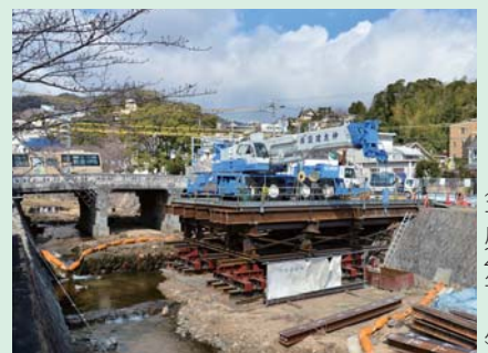
旧開森橋の南側に仮橋を建設中 (平成27年2月)
