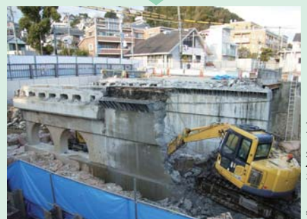
仮橋建設後、旧開森橋を取り壊し (平成28年3月)
