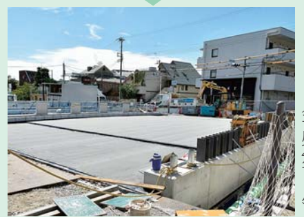
新しい開森橋を建設中 (平成28年9月)
