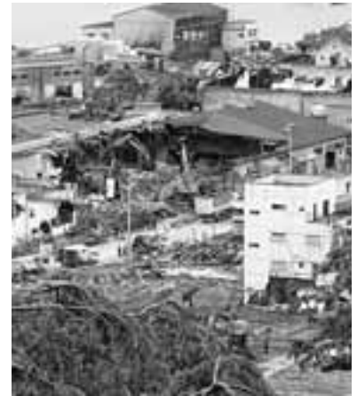
復旧状況(石巻市・5月25日現在)
