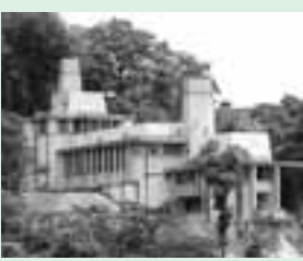
《重要文化財》ヨドコウ迎賓館(旧山邑家住宅)
