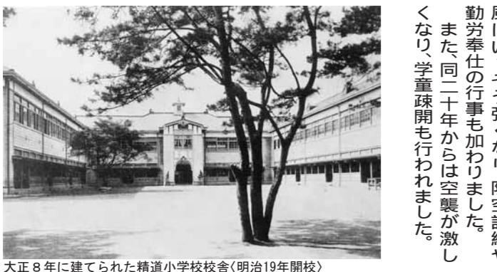
大正8年に建てられた精道小学校校舎(明治19年開校)
