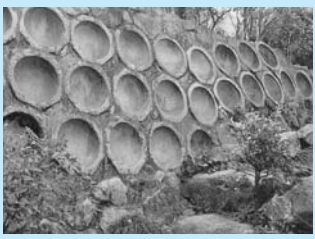
石垣に残された水車臼
