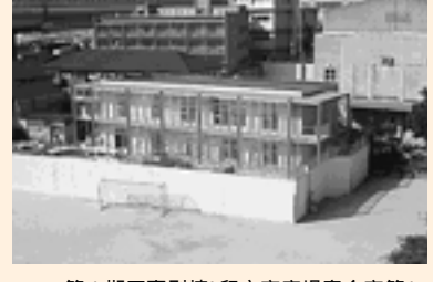
第1期工事別棟(留守家庭児童会室等)
