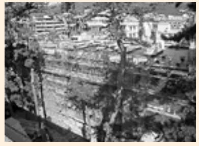
第1期工事特別教室棟
