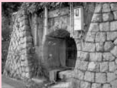
奥谷接合井(朝日ヶ丘町)
