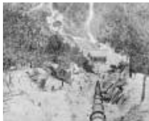
芦屋川水力発電所(大正3年撮影)
