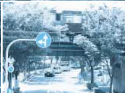
国道2号線上宮川交差点～岩園隧道
