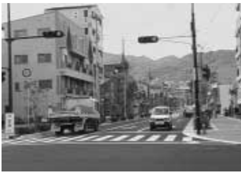
5月13日から2車線の対面通行で供用開始した川東線。
