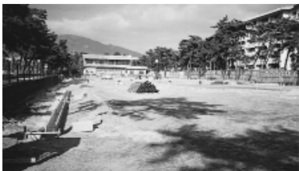
リニューアル・オープンに向けて工事中の芦屋公園テニスコート
