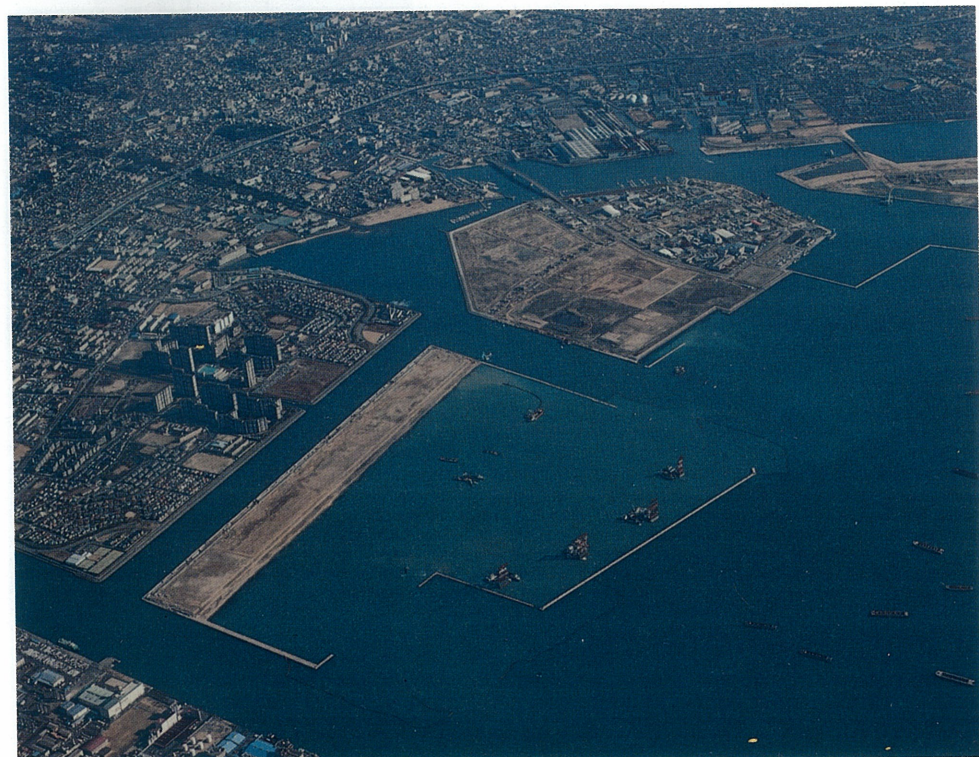
芦屋沖地区埋立地 芦屋沖150メートルに126ヘクタールを埋め立て、親水性を高めるために、マリナーや東西に貫く水路・人工ビーチを設けます。
