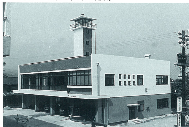
新しくなった消防本部庁舎 昭和37年落成
