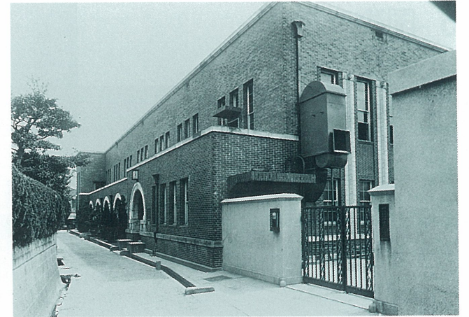
芦屋電報電話局(現NTT) 写真は昭和初期のもの。ドイツ人が設計した。当時はモダンな鉄筋コンクリート造りの建物。
