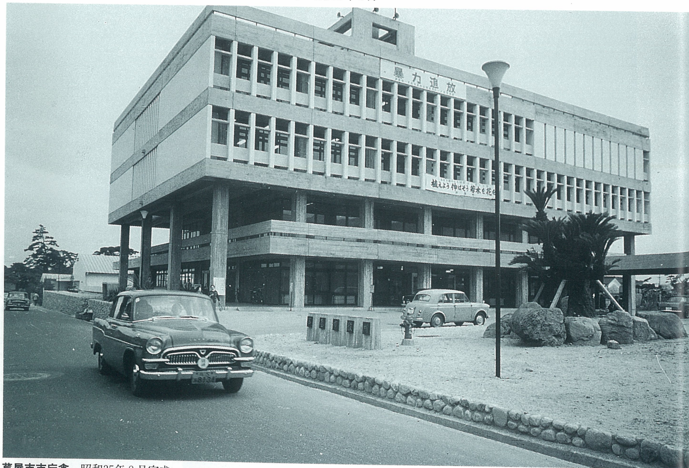
芦屋市市庁舎 昭和35年8月完成
