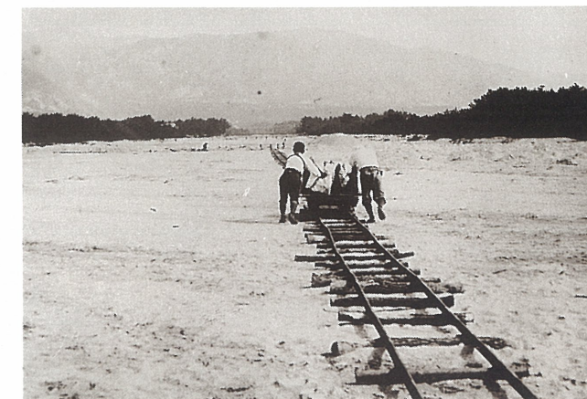
大正初期の芦屋川改修工事風景 この写真からも、川幅の広さがうかがえる。
