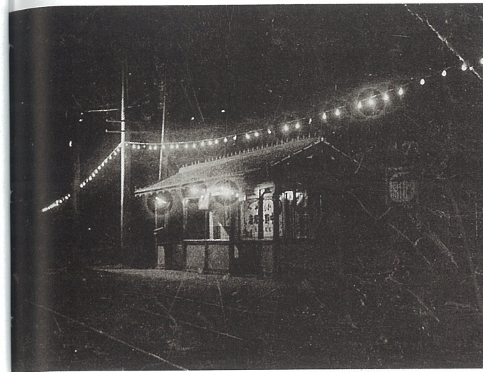
阪神芦屋停留所の夜景 阪神電車が開通したことによって、明治41年10月同社が周辺に電気の供給を開始し、村内に電灯がつくようになった。当時は電車や駅の電灯の夜景がネオンのように美しい印象を与え、見物する人も多かったという。
